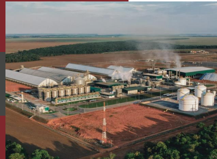
FS Agrisolutions – 2019/2024 – Sorriso – MT Mais de 90mil m 2 construídos.
