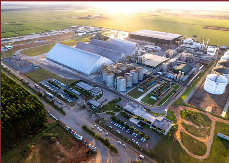
FS Agrisolutions – 2016/2019– Lucas do Rio Verde – MT Mais de 20mil m 2 construídos.
